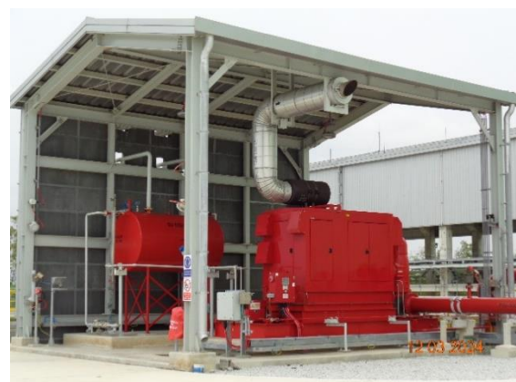
รูปที่ 2-55 เครื่องสูบน้ำทะเลสำรอง โดยใช้น้ำมันดีเซล (Diesel Driven Seawater Fire Pump)
