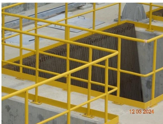
รูปที่ 2-19 ตะแกรงหยาบบริเวณจุดรับน้ำทะเลเข้า
