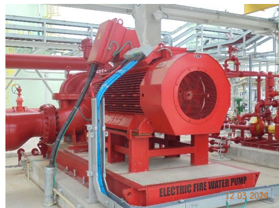
รูปที่ 2-53 เครื่องสูบน้ำใช้ไฟฟ้า (Electric Motor Firewater Pump)
