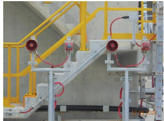
รูปที่ 2-47 อุปกรณ์แจ้งเหตุเพลิงไหม้
