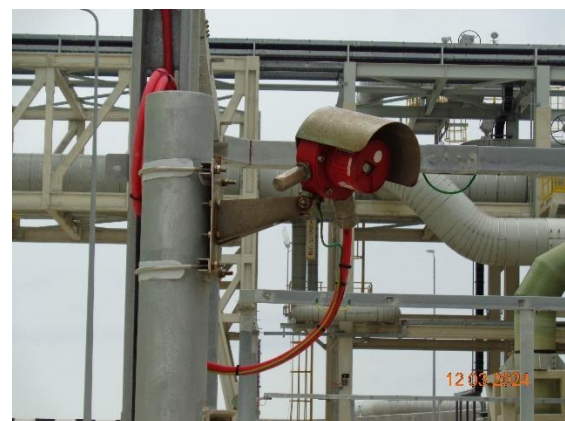
อุปกรณ์ตรวจจับเปลวไฟ (Flame Detector)
