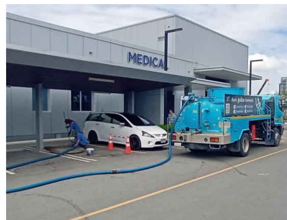
รูปที่ 2-14 การสูบน้ำทิ้งจากระบบบำบัดน้ำเสียไปกำจัด
