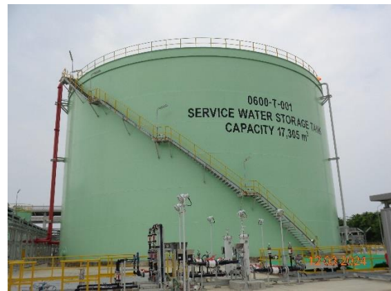
รูปที่ 2-43 ถังเก็บน้ำดับเพลิงขนาด 17,305 ลูกบาศก์เมตร
