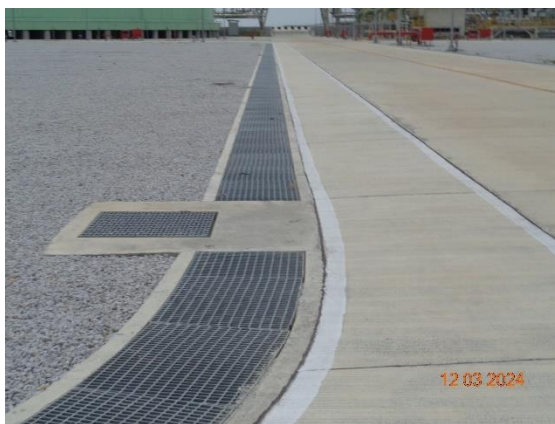
รูปที่ 2-18 ระบบระบายน้ำฝนภายในพื้นที่โครงการ
