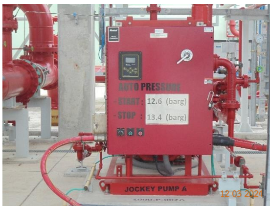
รูปที่ 2-52 เครื่องสูบน้ำแรงดันน้ำ (Jockey Water Pump)
