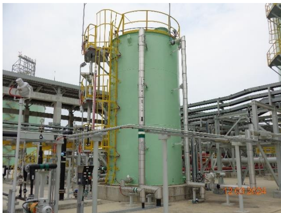
รูปที่ 2-42 ถังเก็บน้ำประปาขนาด 50 ลูกบาศก์เมตร
