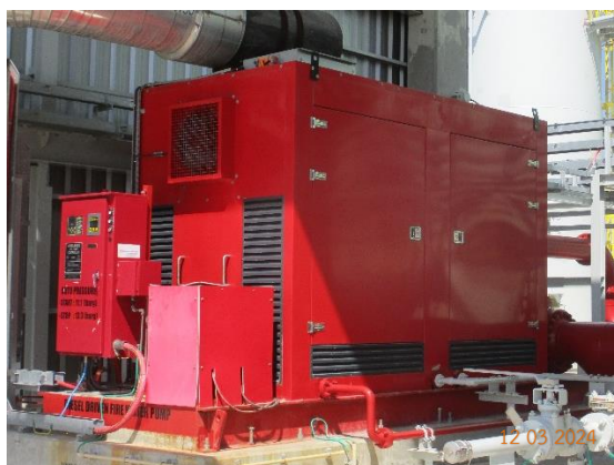
รูปที่ 2-54 เครื่องสูบน้ำใช้น้ำมันดีเซล (Diesel Driven Firewater Pump)
