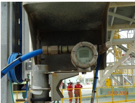
รูปที่ 2-15 อุปกรณ์ตรวจวัดอุณหภูมิของน้ำทะเล อย่างต่อเนื่อง (Temperature Transmitter)
